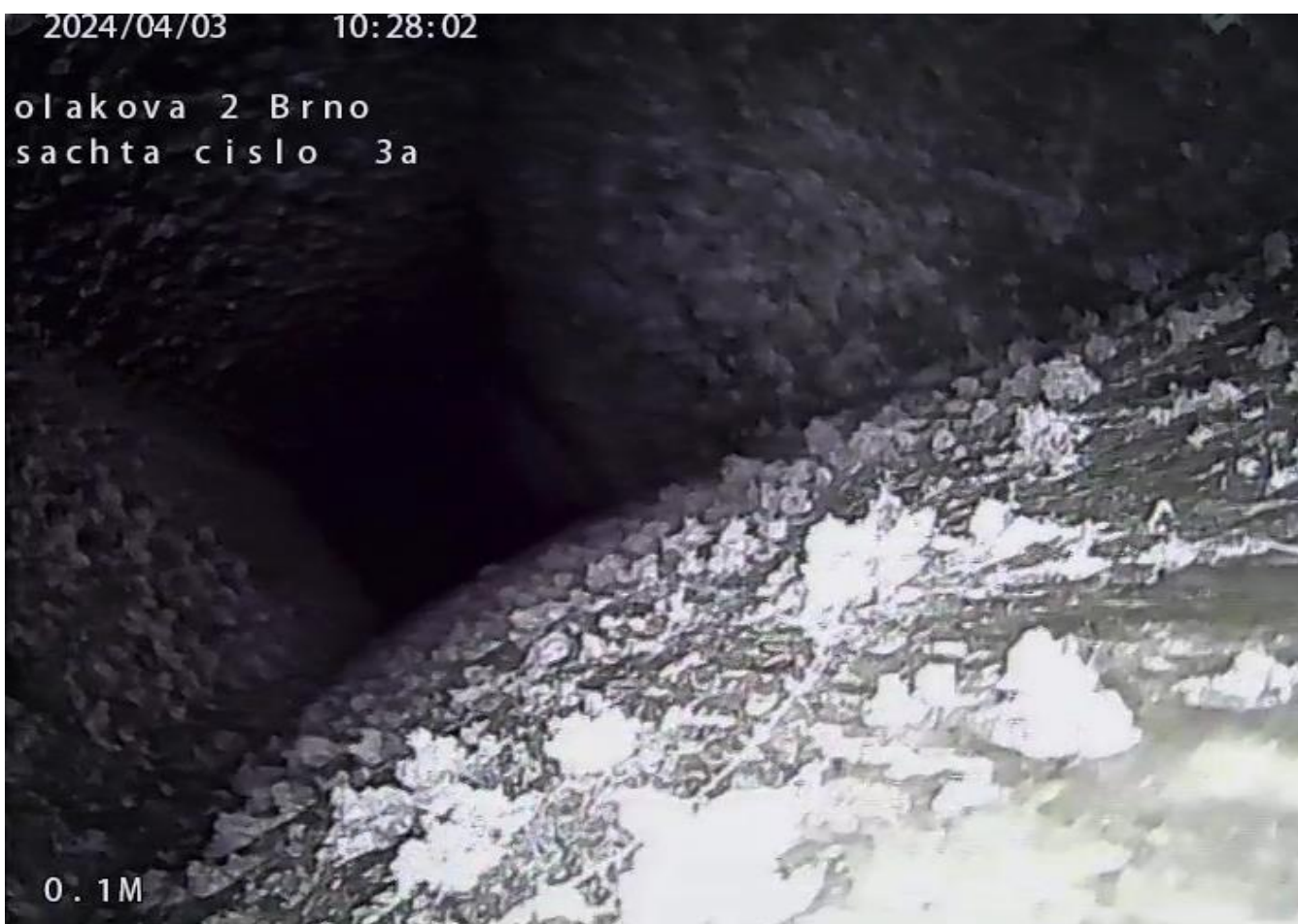
Hrubé nánosy nečistot a plíseň v povlaku nečistoty.
