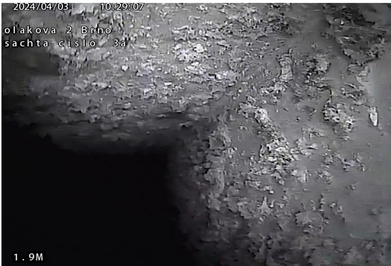
Hrubý nános nečistoty, plísně v povlaku a škodliviny po celém obvodu šachty.
